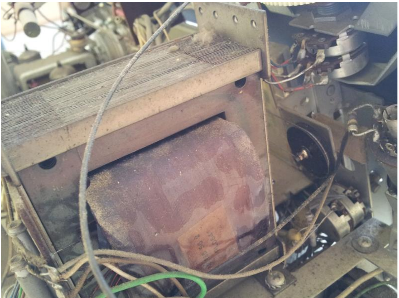
La centrale électrique - le transformateur avec protection d'enroulement intégrée. Vous ne trouverez pas de microfuse conventionnelle dans cet appareil.
